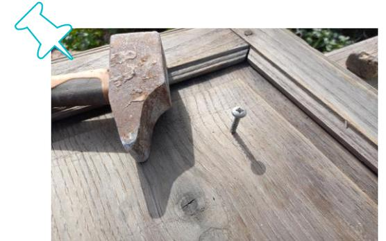
Faire une empreinte dans le bois aux emplacements dessinés précédemment pour les vis de fixation en enfonçant la pointe d'une vis plus grande avec un marteau, puis la retirer délicatement.
