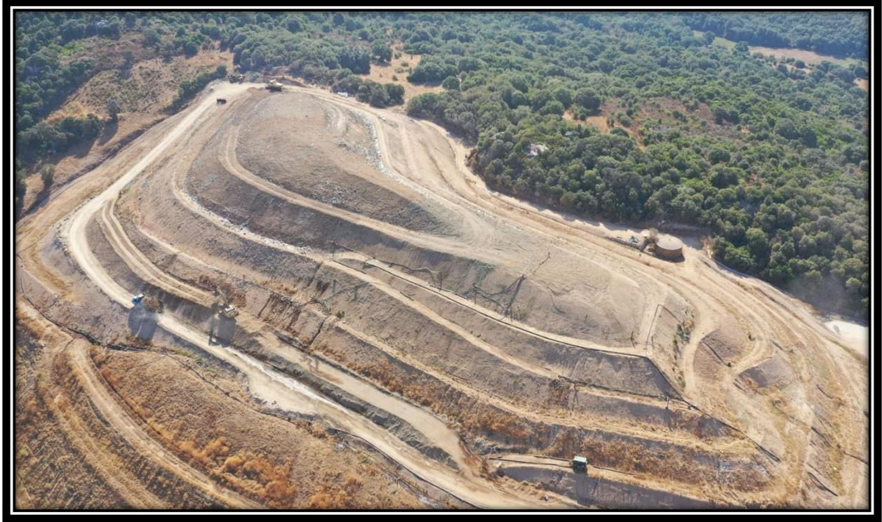
Photo 1 : Casier recouvert avec couverture provisoire
