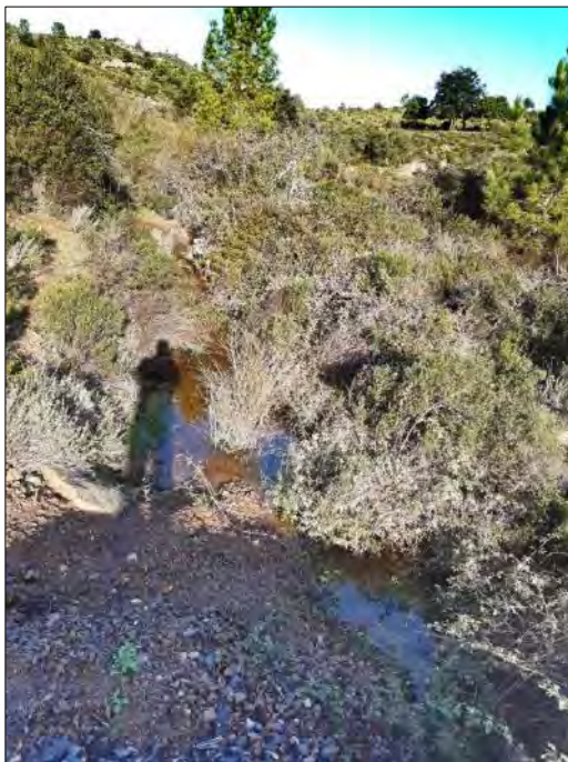
Photographie 9 : Sugitte en eau, en amont de la buse Ø800 mm (source : BURGEAP, le 13/11/2019)
