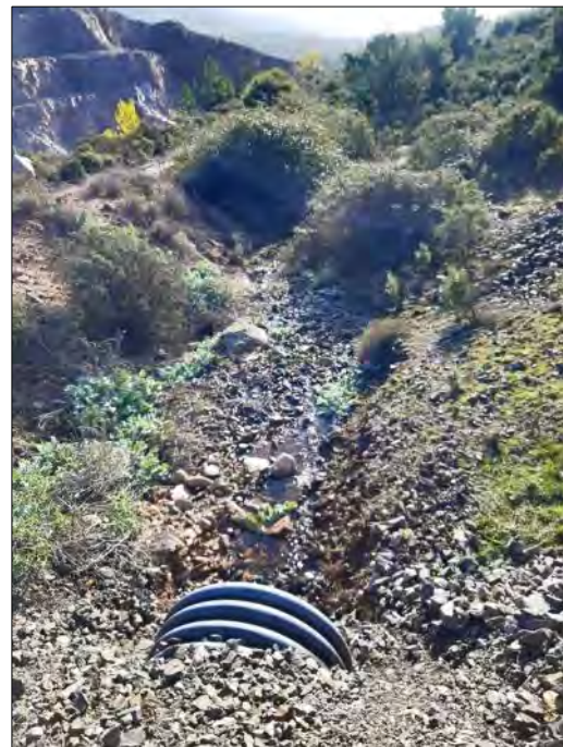
Photographie 10 : Sugitte en eau, en aval de la buse Ø800 mm (source : BURGEAP, le 13/11/2019)
