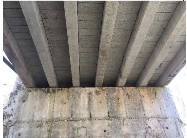
Photos de la pile C et des poutres précontraintes n°P8 à P14
