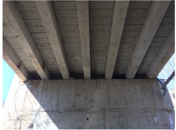
Photos de la pile C et des poutres précontraintes n°P8 à P14
