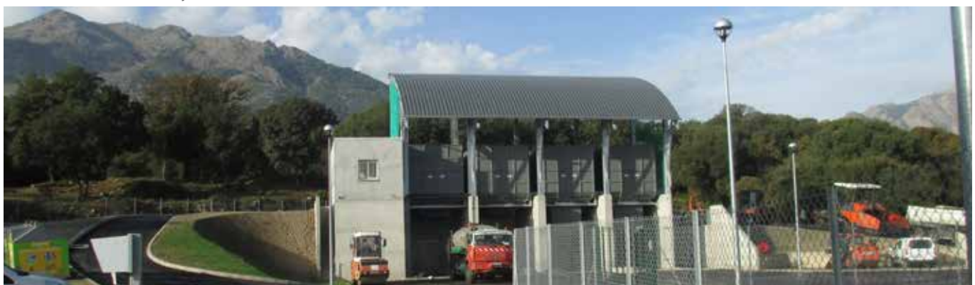
Quai de transfert de Corte ©Syvadec
