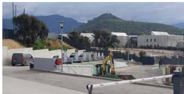
Recyclerie d'Ajaccio-Stiletto rénovée ©Syvadec
