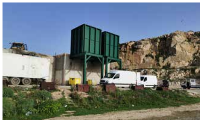
Travaux du quai de transfert de Calvi ©Syvadec
