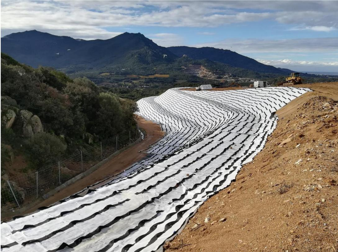
Vue de la couverture finale avant mise en œuvre de la terre de recouvrement (couche d'accroche terre visible)
