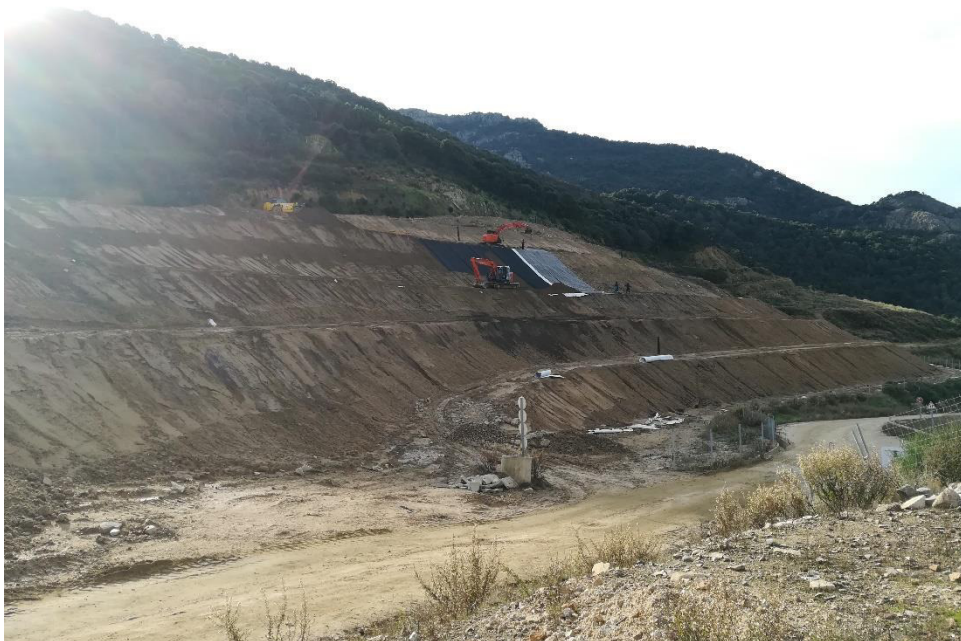
travaux de couverture finale - pose des étanchéités et couverture partielles 4ème talus
