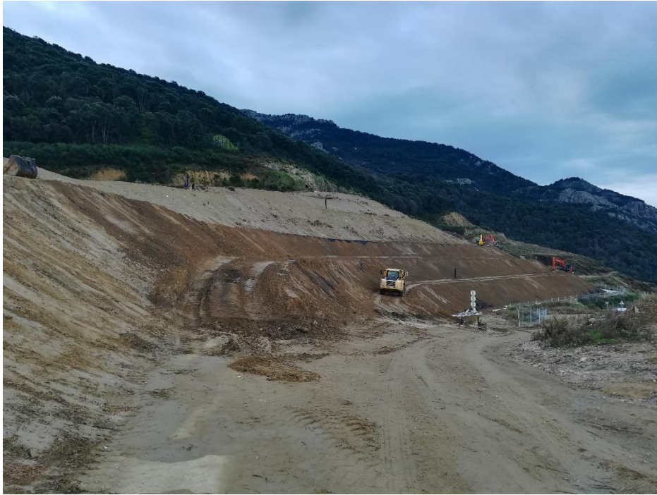
travaux de couverture finale - couverture partielles trois premiers talus
