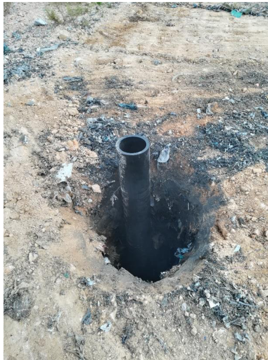
Puit foré et tubé - en attente de mise en œuvre matériaux drainant
