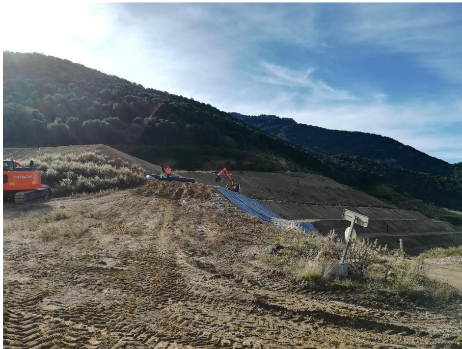
travaux de couverture finale - pose des étanchéités sur les trois premiers talus
