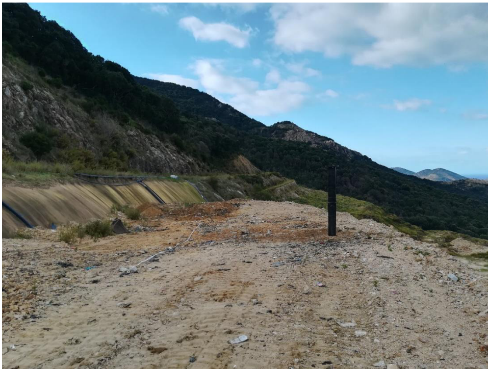
Tête de puit équipée en attente de raccordement sur le réseau
